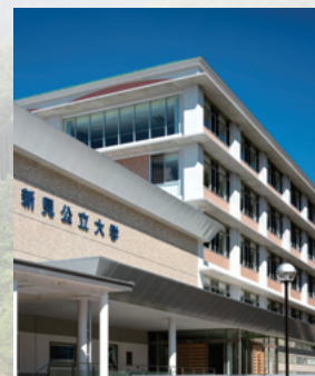
写真3: 地域共生推進センター棟
